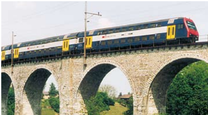
Die S5 verbindet Rafz mit Pfäffikon SZ. 450 023 hat als Zug 18556 soeben den Viadukt von Eglisau verlassen, 1.6.1991.
