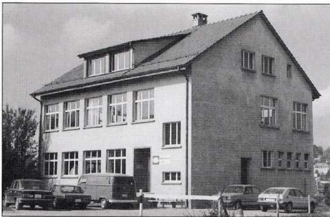
Das erste firmeneigene Gebäude und Sitz von HAG in St.Gallen von 1948 bis 1982.
