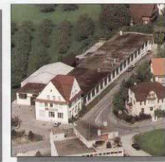
HAG headquarters since 1982 in Wetzwil, between St. Gallen and Lake Constance. La sede della HAG, dal 1982 a Wetzwil, tra San Gallo e il lago di Costanza.
